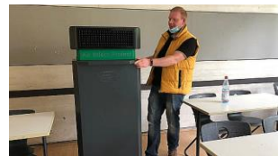
Installation der Luftfilter im Neubau des DBG Quelle: SWR 4
